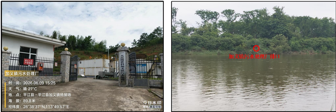
图 3-8 加义镇污水处理厂及排口照片
