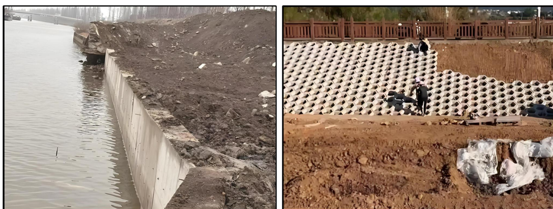
图 2-3 砼挡土墙+六方块护坡典型图
