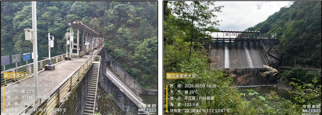
图 3-10 丽江水库大坝照片
