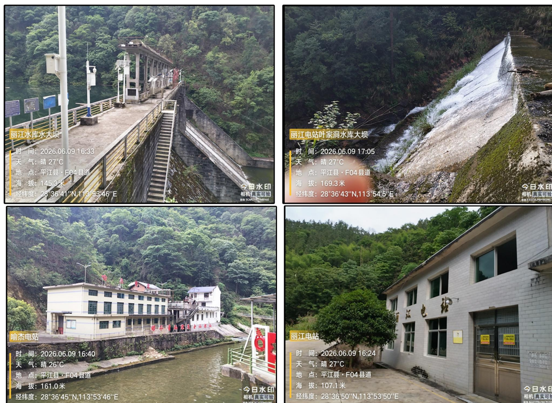
图 3-5 喻杰电站和丽江电站厂房照片
