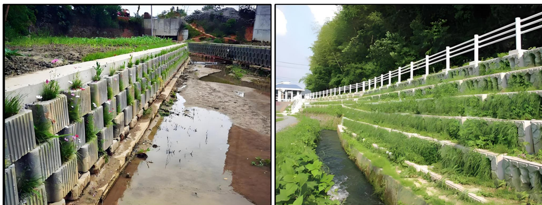
图 2-3 生态挡墙护岸典型图
