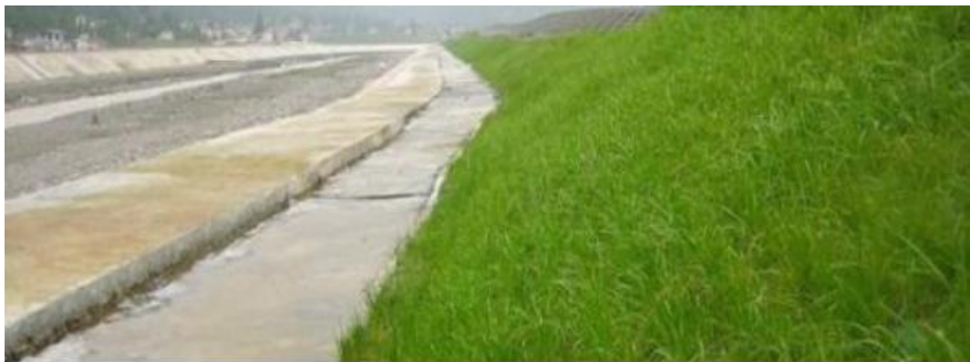
图 2.1 草皮护坡示意图
