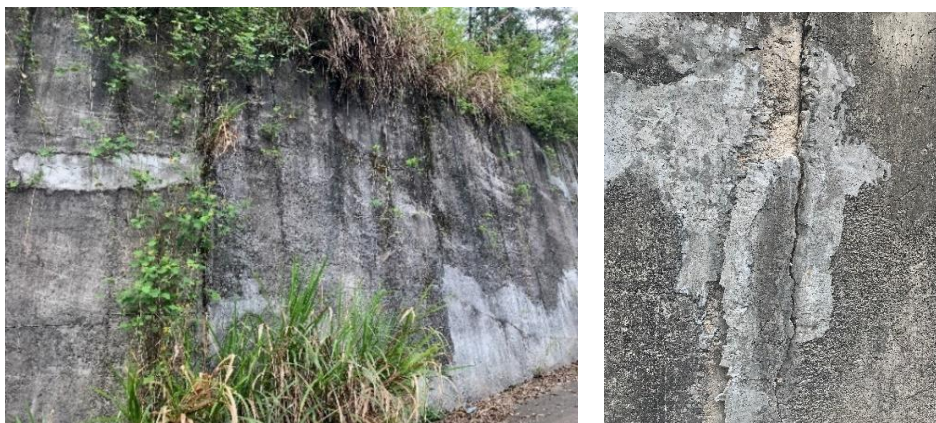
图 3.3 溢洪道侧墙现场照片
