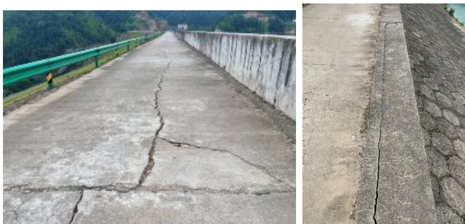
图 3.1 坝顶路面及防浪墙现场照片
