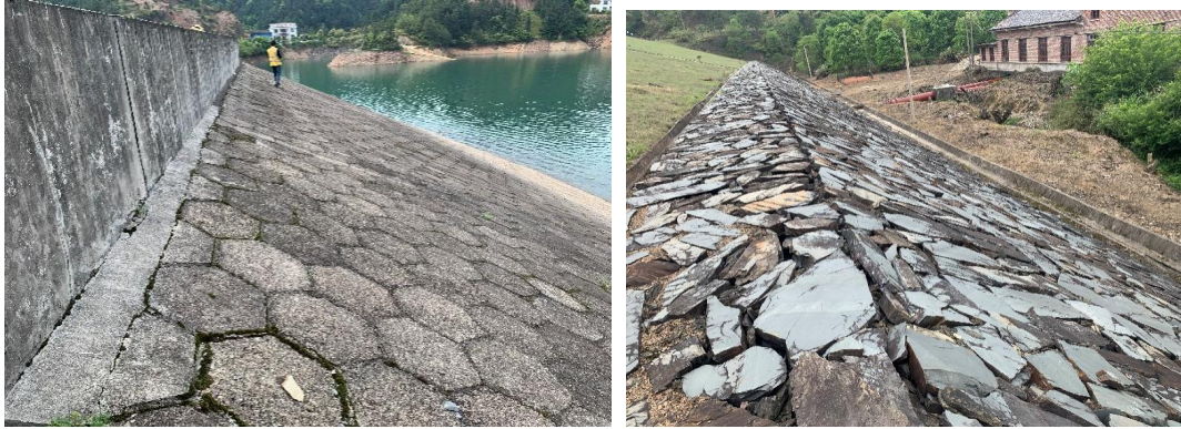
图 3.2 上游一级坝坡砼六方块护坡及排水棱体现场照片
