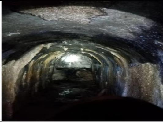
输水涵洞裂缝
