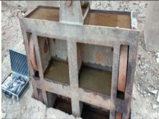
溢洪道泄槽闸门老化
