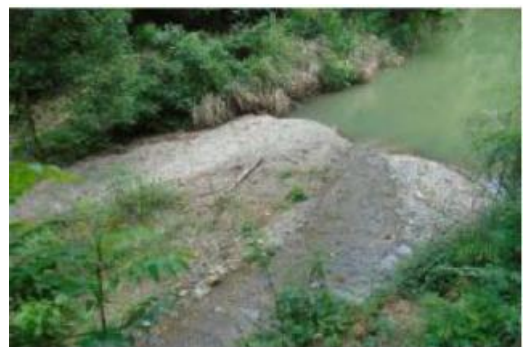
6#漆家组横洞里废渣堆积现状
