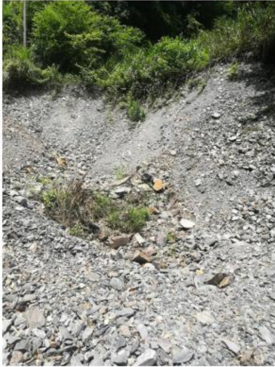
1#老屋组废渣堆积现状
