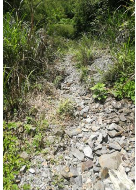
2#株树组废渣堆积现状
