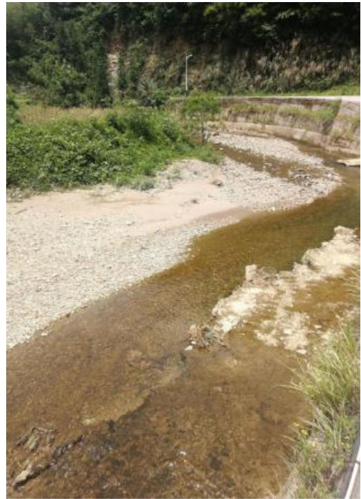
4#黄沙村河道废渣堆积现状
