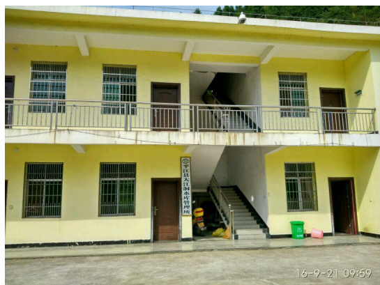
图 3.1-1 大江洞水库管理所
