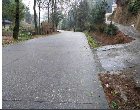
线路起点现状
