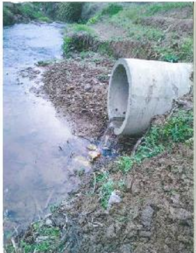
图为：平江县2016年实施的(300-500人)集中式污水处理人工生态湿地处理设施,处理后排放的水质。图为余坪镇集中式污水处理和稻田村集中式污水处理水质排放图
