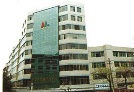
公司承建的县广电中心
